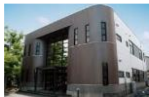
6kV級で受電する事務所、工場等
