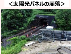
<太陽光パネルの崩落>
