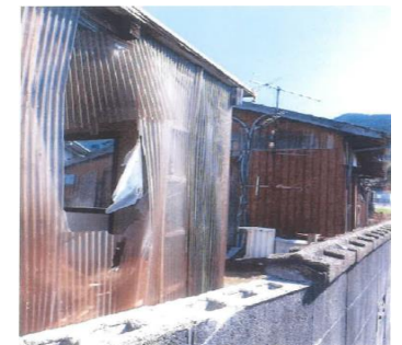
破損した民家
