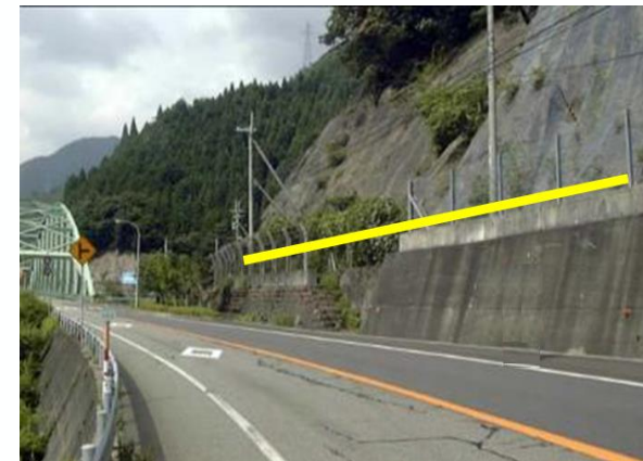
山地の道路沿いの擁壁上部
