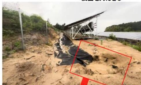
写真のように釜場を設け、少し高い位置に排水ダクトを設置し、流速が落ちた上澄みだけを下流に導く。
