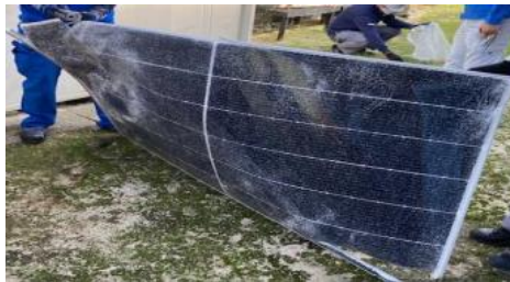
民家の庭に散乱したモジュール
