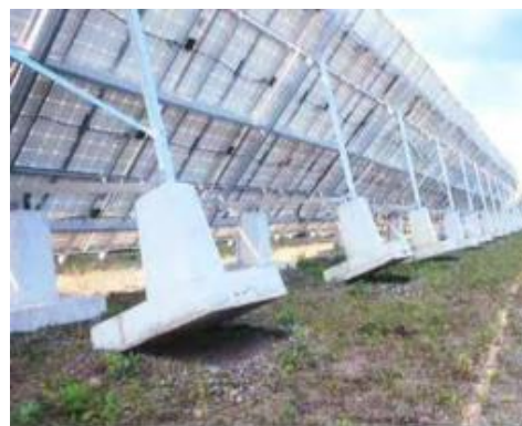
強風で架台が持ち上がり傾き
