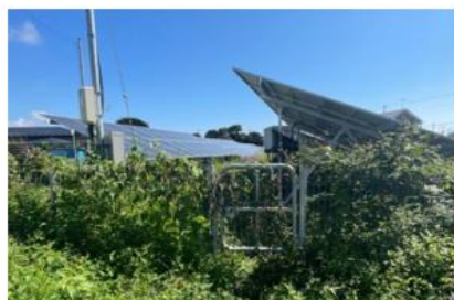
管理不十分な状態で下草に覆われたパネル 基礎が露出し浮いている太陽光発電設備
