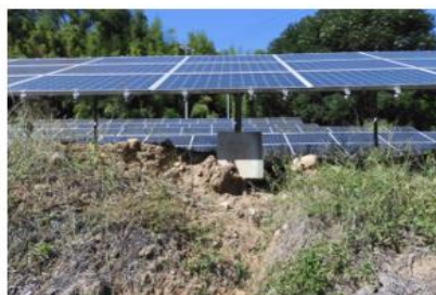
管理不十分な状態で下草に覆われたパネル 基礎が露出し浮いている太陽光発電設備
