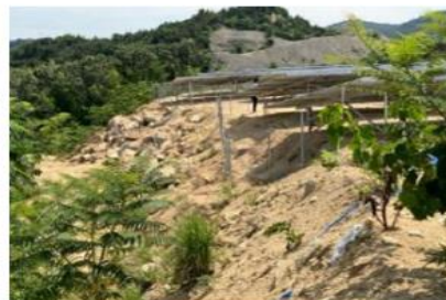
盛土が大きく崩落した太陽光発電設備
