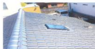
屋根上に飛散したモジュール
