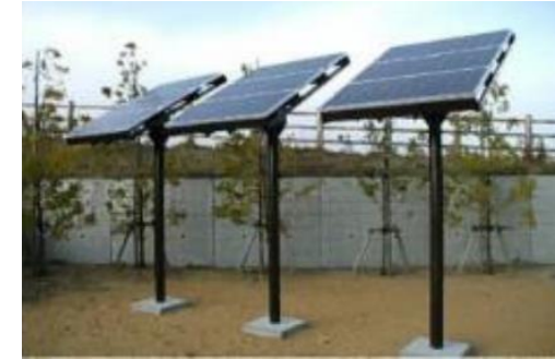
既存のシリコン太陽電池パネル上への設置
