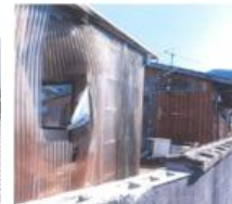
屋根上に飛散したモジュール 破損した民家
