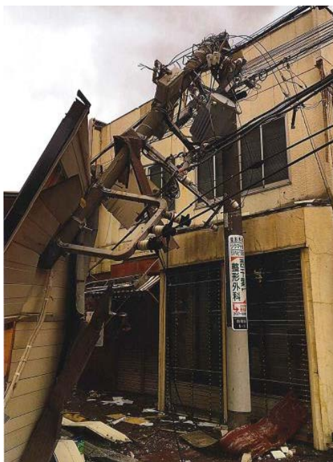
建物倒壊による電柱倒壊（千葉エリア）
