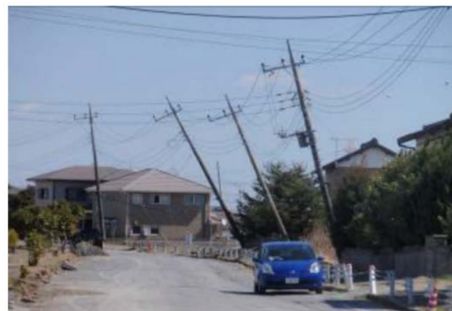
液状化に伴う電柱傾斜（茨城県潮来市）
