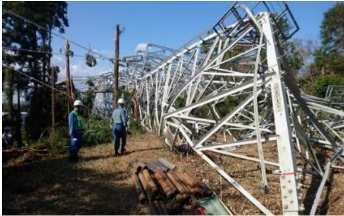
＜鉄塔基礎の状況（No.78）＞
