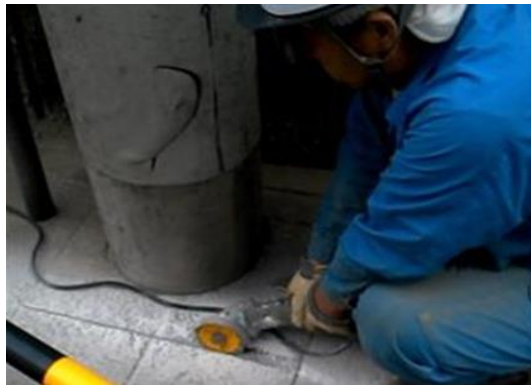
補強板挿入のための掘削
