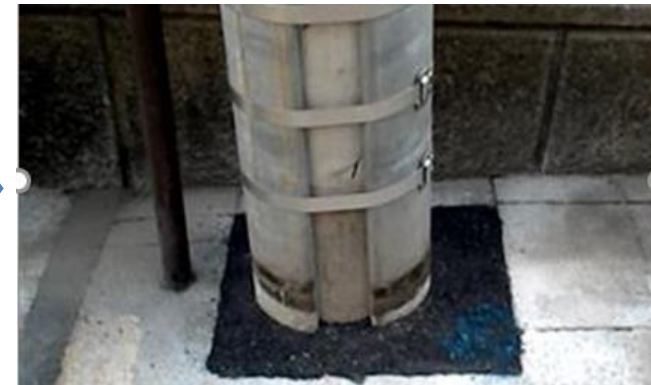
再舗装（アスファルト舗装）
