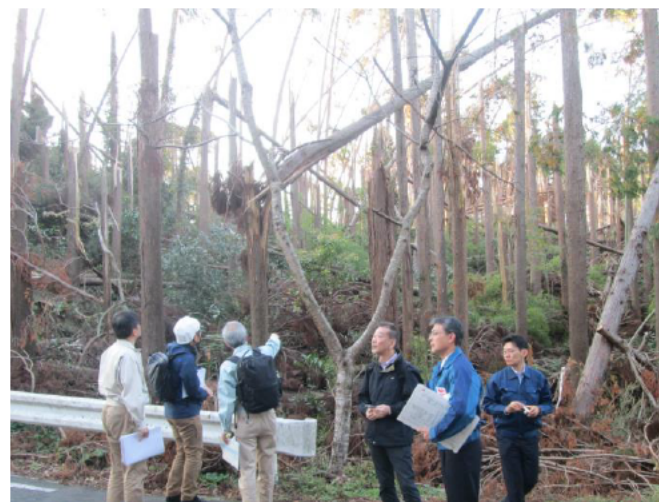
＜倒壊現場近辺の森林の様子＞
