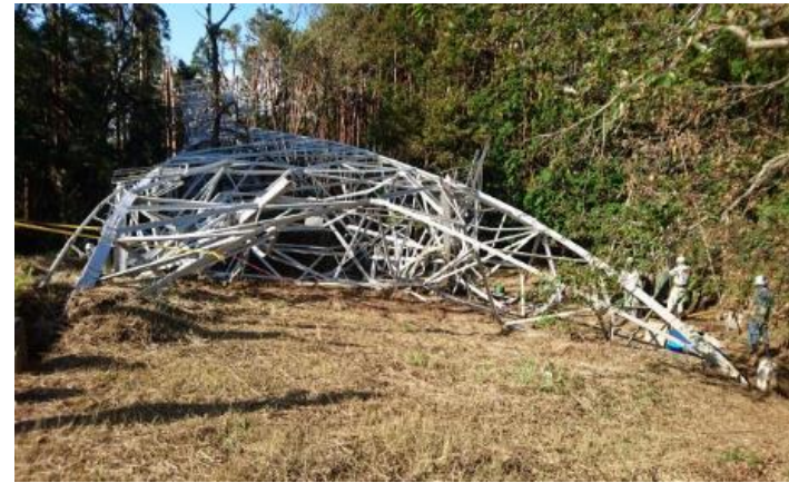
＜鉄塔基礎の状況（No.79）＞
