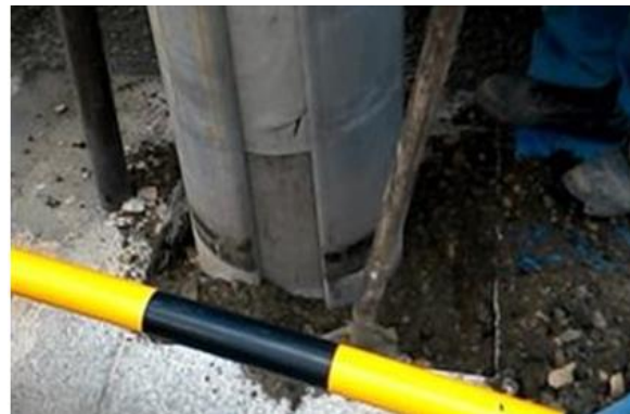
補強板の挿入、固定
