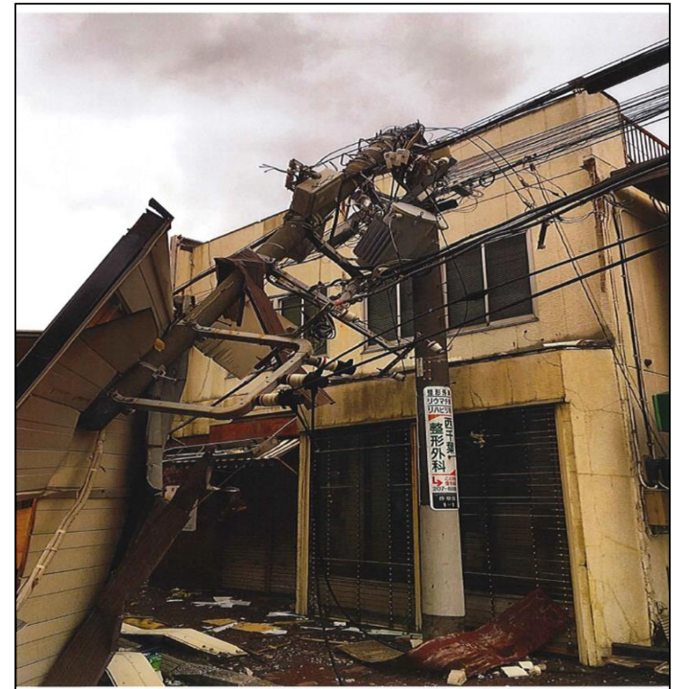
<写真の一例（飛来物による折損）>
