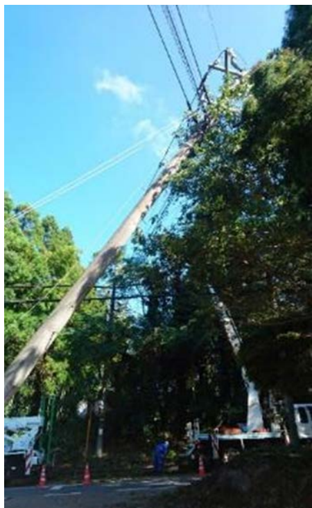
＜倒木・飛来物による電柱損壊現場の様子＞
