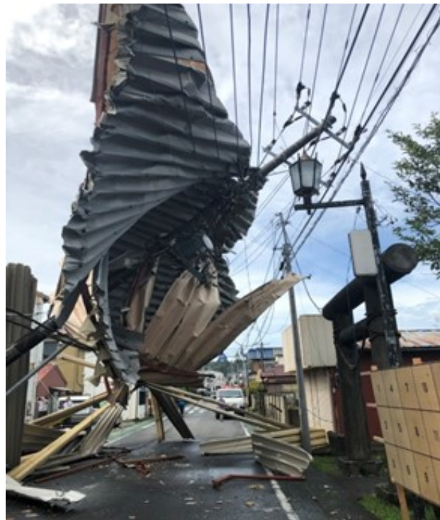
＜倒木・飛来物による電柱損壊現場の様子＞
