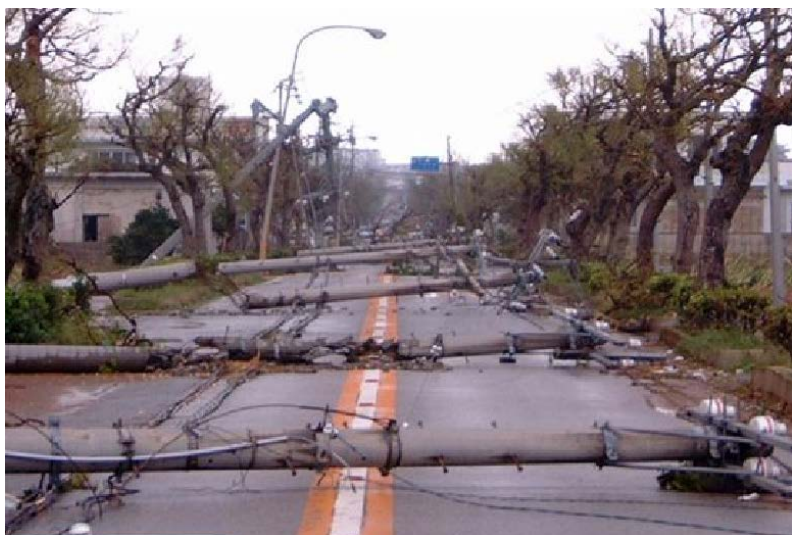
＜連鎖倒壊の様子＞
