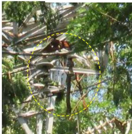
写真⑬ 小糸川線2L 本線がいし
