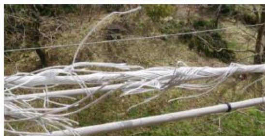
写真⑦ 内房線2L上相 電線
