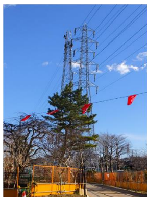
(鉄塔建替え工事の様子)
