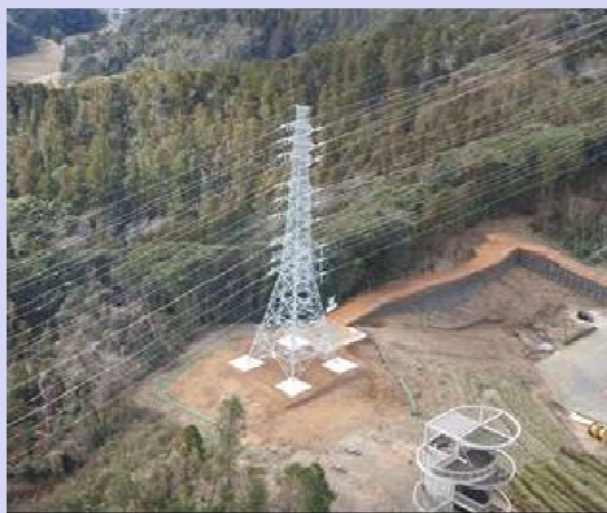
復旧した木内線No.78
