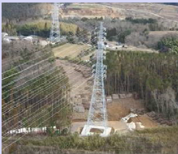
復旧した木内線No.79
