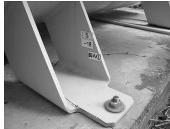
図 I - 2 3 バルク貯槽の固定例
