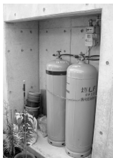
建物の凹み部分への設置例
