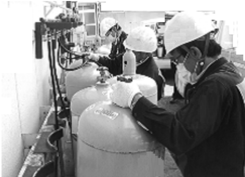
避難所にLPガス供給設備を設置
