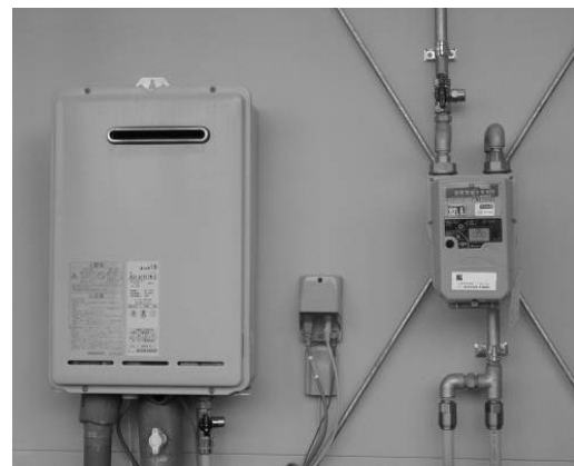
仮設住宅での給湯器設置
