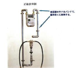
調整器固定部
