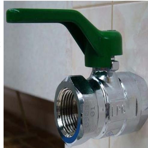
中間ガス栓に用いられる「ねじガス栓」は、末端ガス栓と比較して耐久性が低く、ロック機構がないため（レバーが左右に振れることで栓が開閉するため）、末端ガス栓に用いると危険です。
