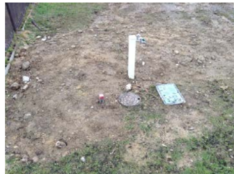
※（現場写真）掘削箇所
