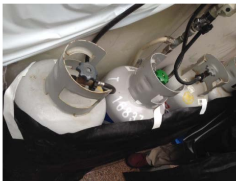
※（現場写真）高圧ホースと容器の接続部
