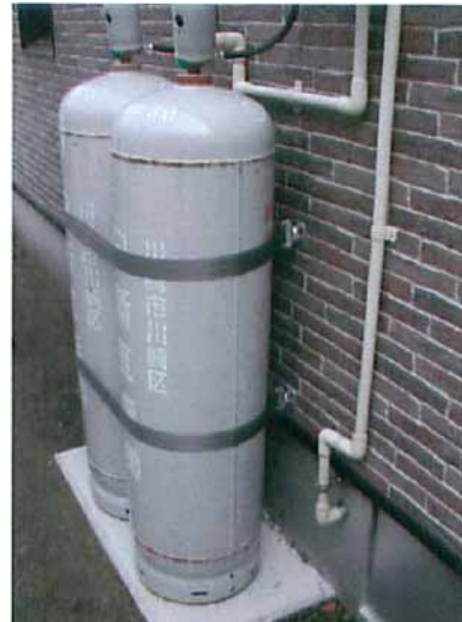
【LPガス容器の転倒防止対策例】
