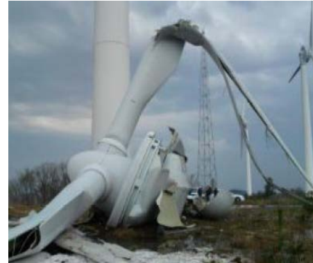
強風により損壊した風力発電設備 (平成25年3月京都府太鼓山)
