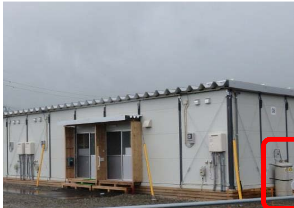
仮設住宅でのL Pガス利用
