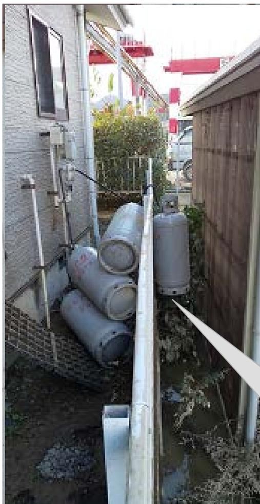
浸水により浮き上がり容器が倒れたが高圧ホースで流出が防がれている。
