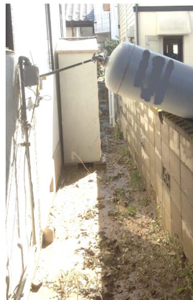
〈洪水被害を受けた供給設備〉
