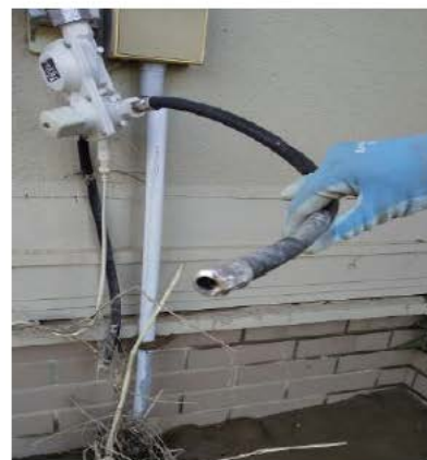
③浸水による高圧ホースからの断絶
