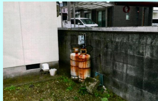
LPガス保安情報説明会における (一社)和歌山県LPガス協会発表資料より
