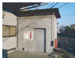
② 貯蔵施設
