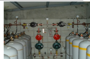
簡便な特定ガス発生設備（ボンベ小屋）
