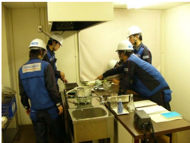
漏えい調査（灯内内管）
