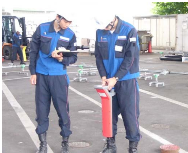
配管の位置調査
