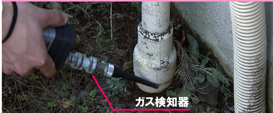
内管検査時に一括して行う接続具・消費機器の漏えい確認
