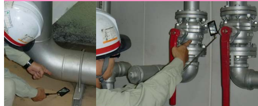
内管検査時に一括して行う接続具・消費機器の漏えい確認
