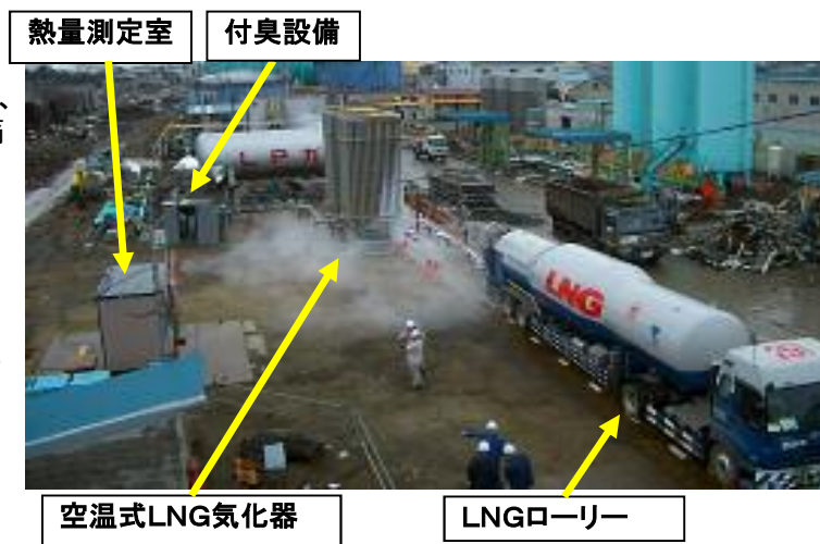
<製造所において臨時製造設備が設置され、活用された例>
