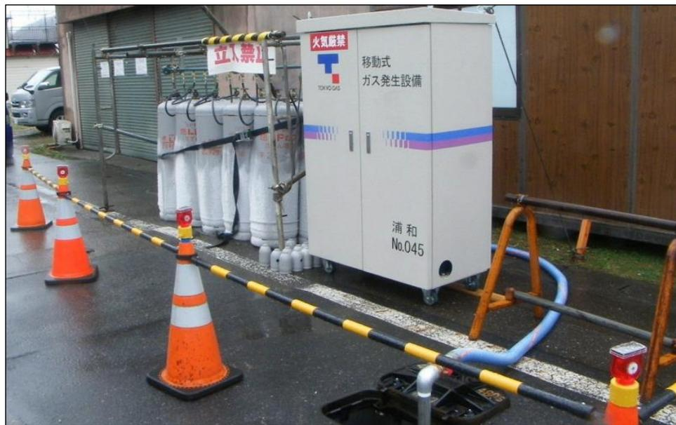
移動式ガス発生設備(PA13A)の設置状況
