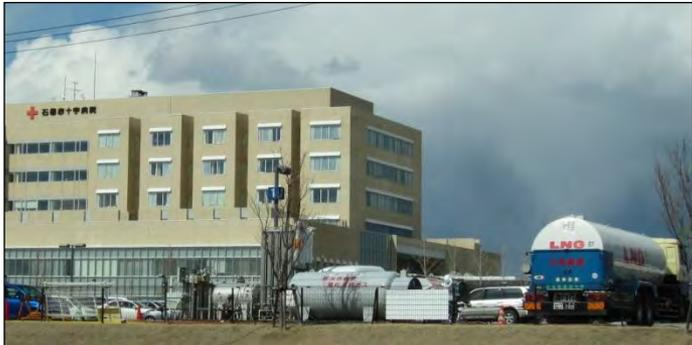
LNGローリー+移動式ガス発生設備(50m<sup>3</sup>/h)による臨時供給
