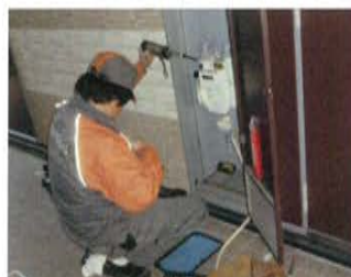
漏れ箇所を探す①
