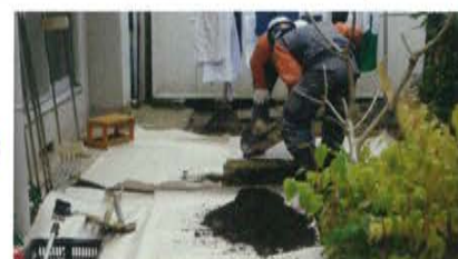
漏れ箇所を応急修理する
