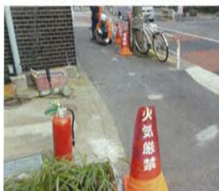
漏れ箇所を探す②
