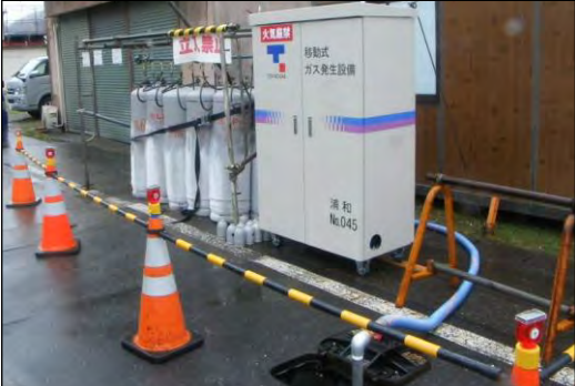
移動式ガス発生設備(PA13A)の設置状況
