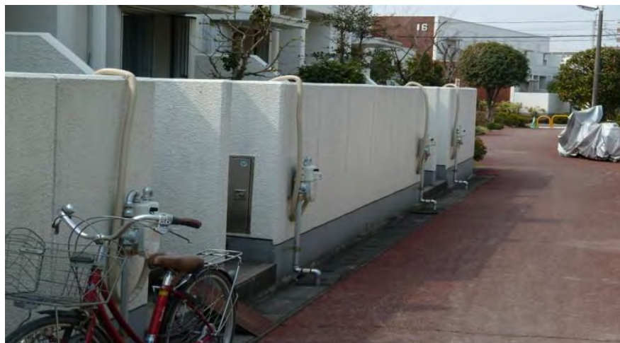
フレキシ管による仮設配管
