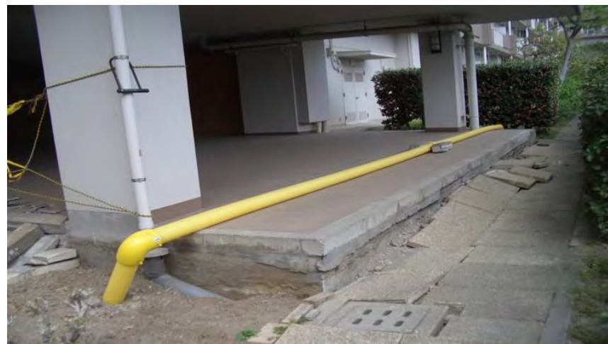
ポリエチレン管による仮設配管
