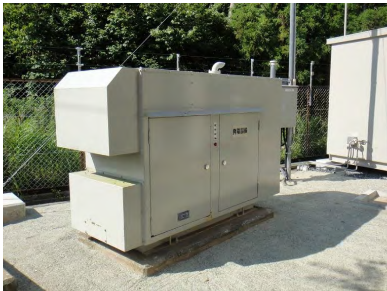
【非常用発電設備設置状況】
