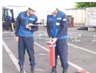
配管の位置調査
