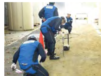
漏えい調査(灯外内管)
