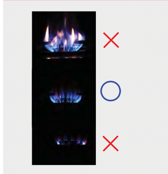
消費機器調査時に機器の燃焼性を確認
