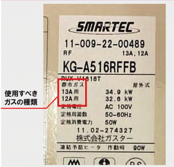
消費機器調査時に機器の供給ガスに対する適合性を銘板等により確認
