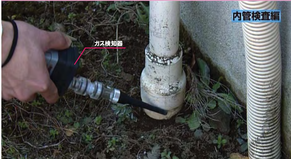
屋外の露出配管の漏えい検査 (ガス工作物の技術上の基準を定める省令 第51条 第2項 第4号 により漏えい検査の適用が除外されている)
