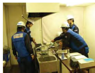
漏えい調査(灯内内管)
