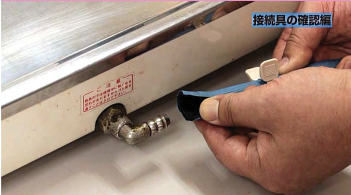
接続具を起因としたガス漏れ事故防止対策として、接続具の確認を消費機器調査時に実施
