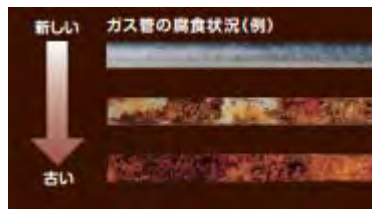
土の中に埋められた亜鉛メッキ導管 (白ガス管) の例
