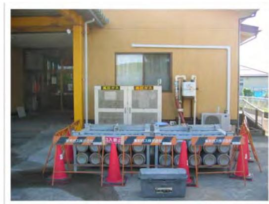
移動式ガス発生設備の例
