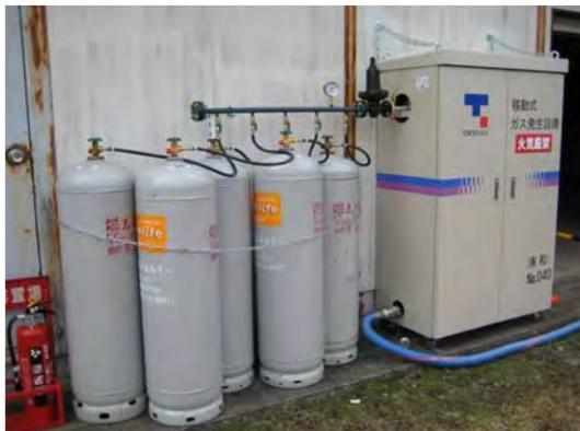
移動式ガス発生設備の例
