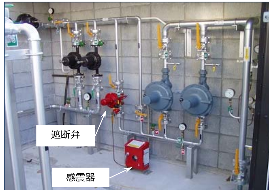
感震自動ガス遮断装置の設置例
