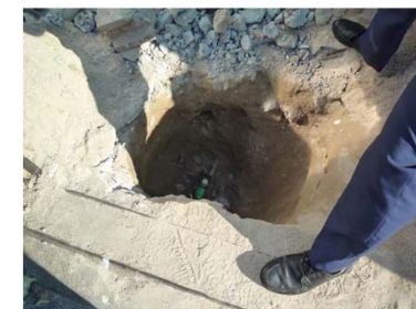
【事故現場の掘削穴】
