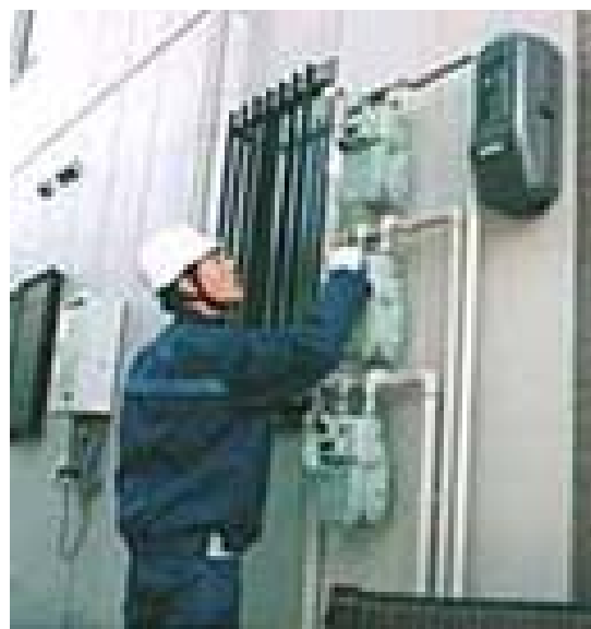
閉開栓作業（顧客対策隊）
