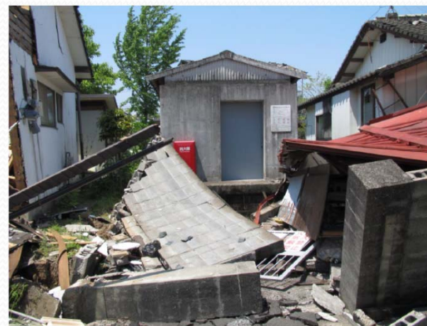
周囲建物のブロックが倒壊した事例 (製造所そのものに被害なし)
