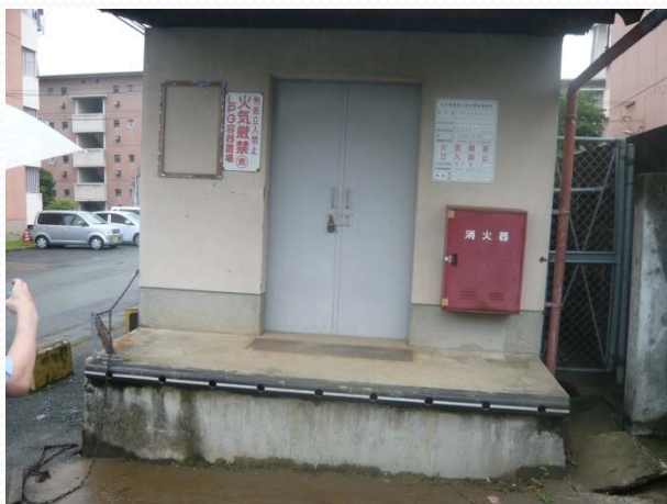
液状化により傾いた製造所 (製造設備に被害なし)
