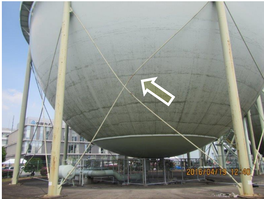
タイロッドブレースの伸び(設計許容範囲内)
