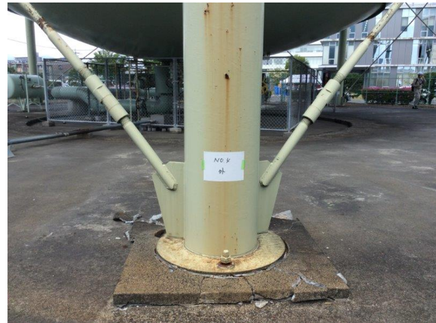
基礎の一部ひび割れ
