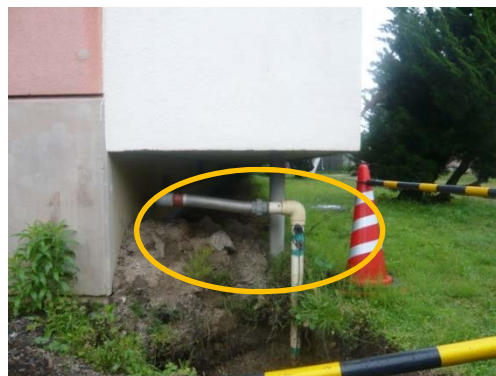
写真4 灯外内管 液状化によって立ち上がり部が沈下した
