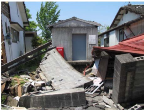
写真1 特定製造所 コンクリートブロック塀の倒壊
