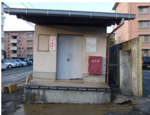
写真3 特定製造所（正面） 液状化により特定製造所の建屋が傾いた
