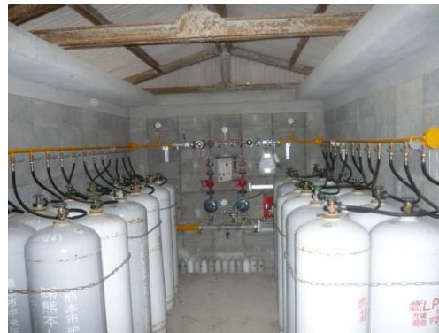
写真2 特定製造所 内部 配管類等は異常無し
