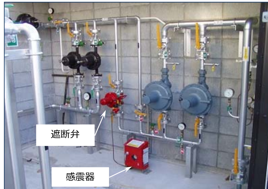
感震自動ガス遮断装置の設置例
