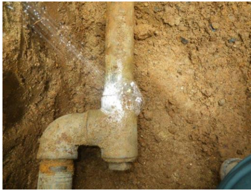
写真1 支管ねじ接合 その1
