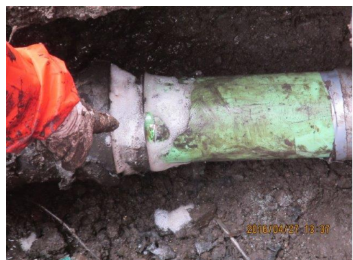
写真8 支管機械的接合 その1 (拡大)
