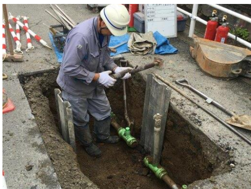
写真13 本支管修繕 その2
