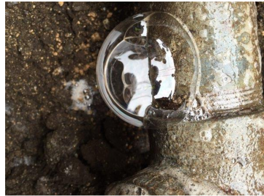
写真2 支管ねじ接合 その2
