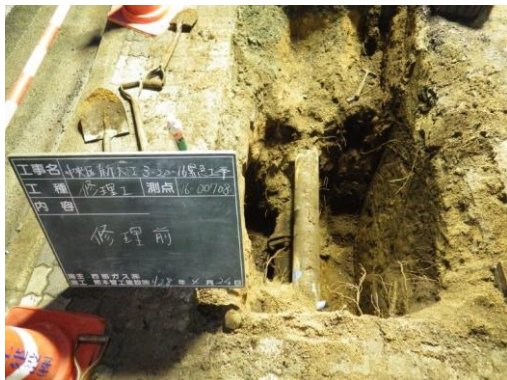
写真5 本管機械的接合 その2
