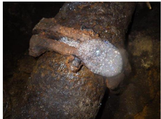
写真6 本管機械的接合 その2 (拡大)
