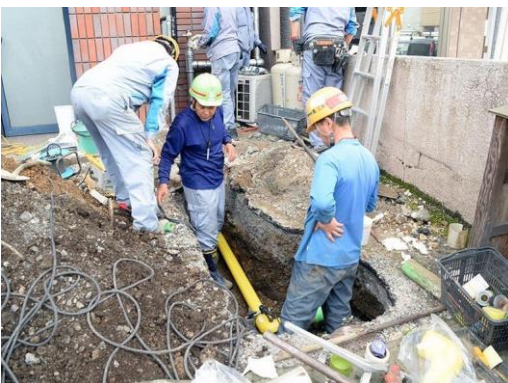
写真15 内管修繕 その1
