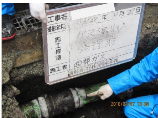
写真7 支管機械的接合 その1
