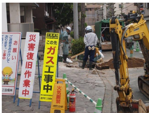
写真12 本支管修繕 その1
