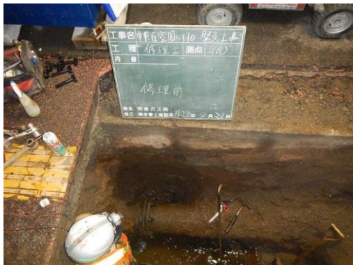
写真3 本管機械的接合 その1
