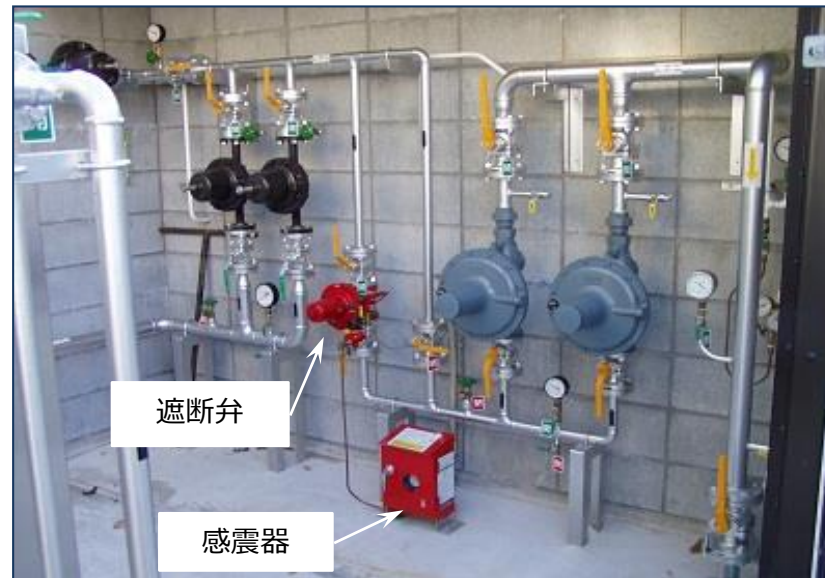
感震自動ガス遮断装置の設置例
